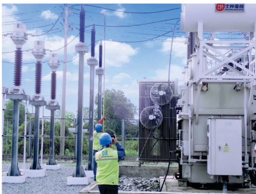
Công trình bảo trì bảo dưỡng MBA trạm 220kV và OLTC operation and regular maintenance of 220kV and OLTC
